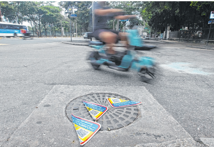
Registro de placas do Rotativo Digital danificadas no Flamengo
